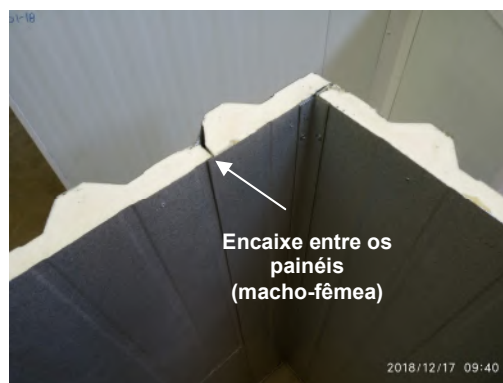
Foto 5 – Detalhes da junta e do miolo dos painéis.
