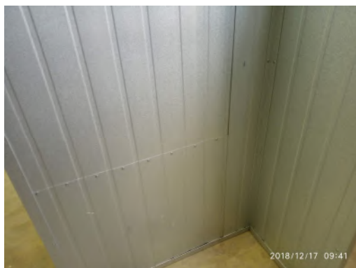
Foto 2 – Montagem dos corpos de prova - painéis.
